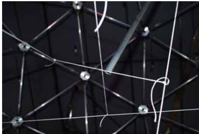
Abbildung 3.13.: Foto der gespannten Schnüre zur Bestimmung des Kugelmittelpunktes. Mit Hilfe der Alustange werden die Sternelemente ausgerichtet.
